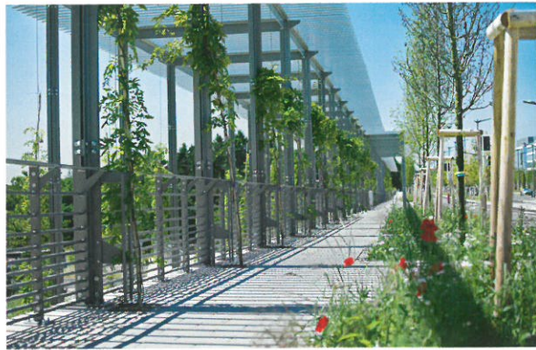
Eine Pergola fasst die Avenue J. F. Kennedy auf dem Plateau de Kirchberg in Luxemburg im Bereich Bricherhof. Natursteinmauern fangen den Niveauunterschied ab.
