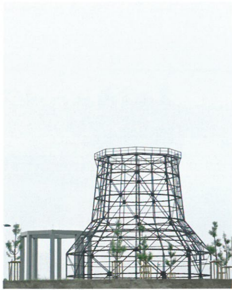
Lohrer.Hochrein erhielten im Park Phoenix West einzelne Relikte des Hütten- und Stahlstandorts wie etwa das Stahlgerippe eines ehemaligen Kühlturms.
