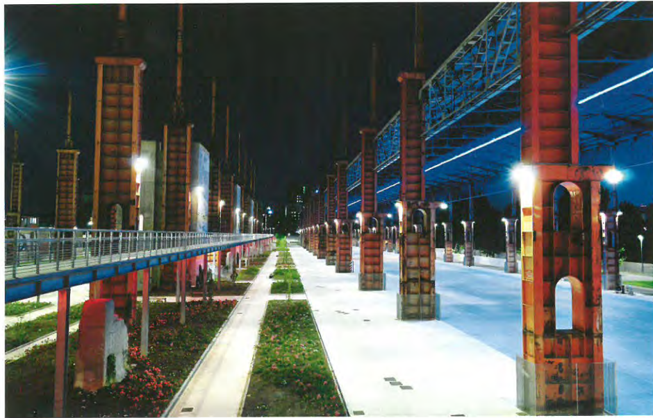
Die Hauptelemente des Parco Dora in Turin sind eingespannte Stützen einer Gießerei, deren Hülle nicht erhalten werden konnte. Zusammen mit den Beton-Treppenhäusern sind sie das Grundgerüst für den „Eisernen Dschungel“.
