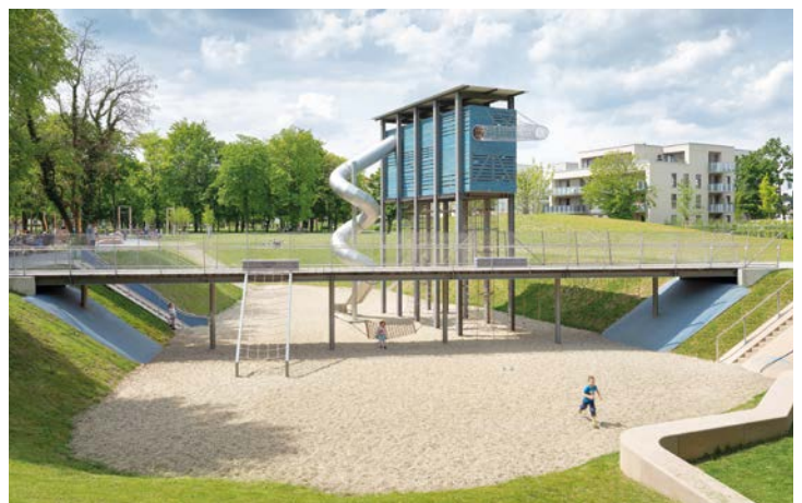
Früher stand hier ein Gebäude, jetzt ist die Mulde mit dem spektakulären Kletterturm in eine besondere Spielfläche umgewandelt.
